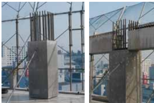
図1 高強度プレキャストコンクリート (左は柱部材、右は柱部材に梁部材 を取り付けた様子。)
