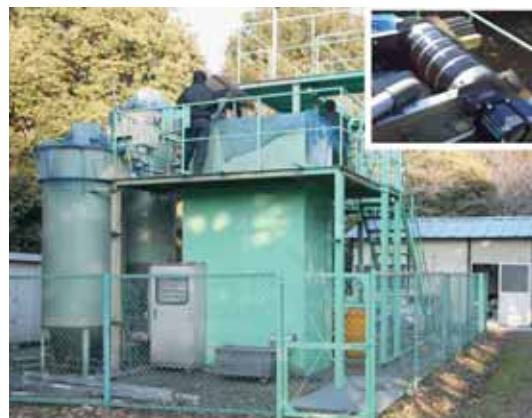
図 1. 80 人規模の下水処理パイロットプラント (宇都宮市水再生センター) 右上は 2013 年に設置された強磁力クーラントセパレーター
