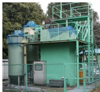
宇都宮市水再生センターの磁化活性汚泥パイロットプラント (80人分相当の下水を連続処理している、曝気槽 8m³)
